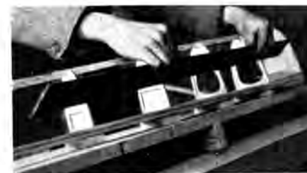
Abb. 101. Ausrichten der Rippen.
