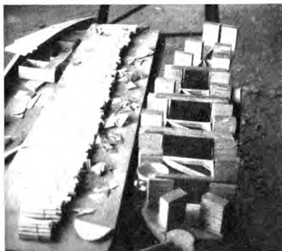
Abb. 51. Rippenkasten mit vorgerichteten Ecken u. Leisten.
