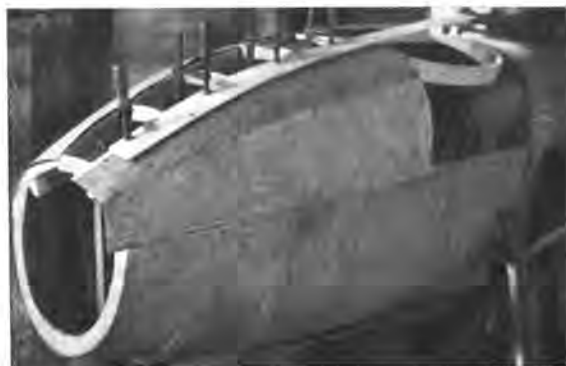
Abb. 130. Sperrholz wurde teilweise aufgezogen.
